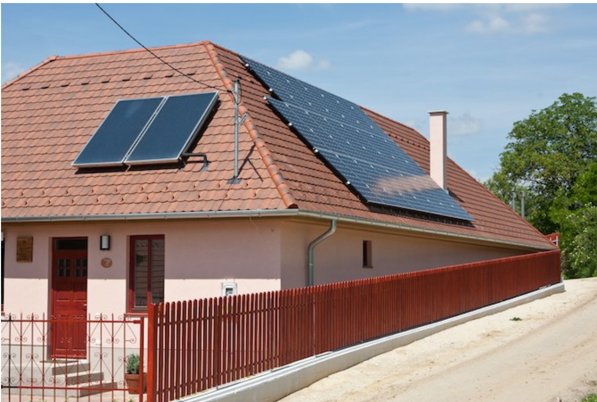
3. kép: 6,56 kWp fotovoltaikus napelem rendszer (jobbra) és napkollektorok (balra) az Irota EcoLodge Középső Házában.
