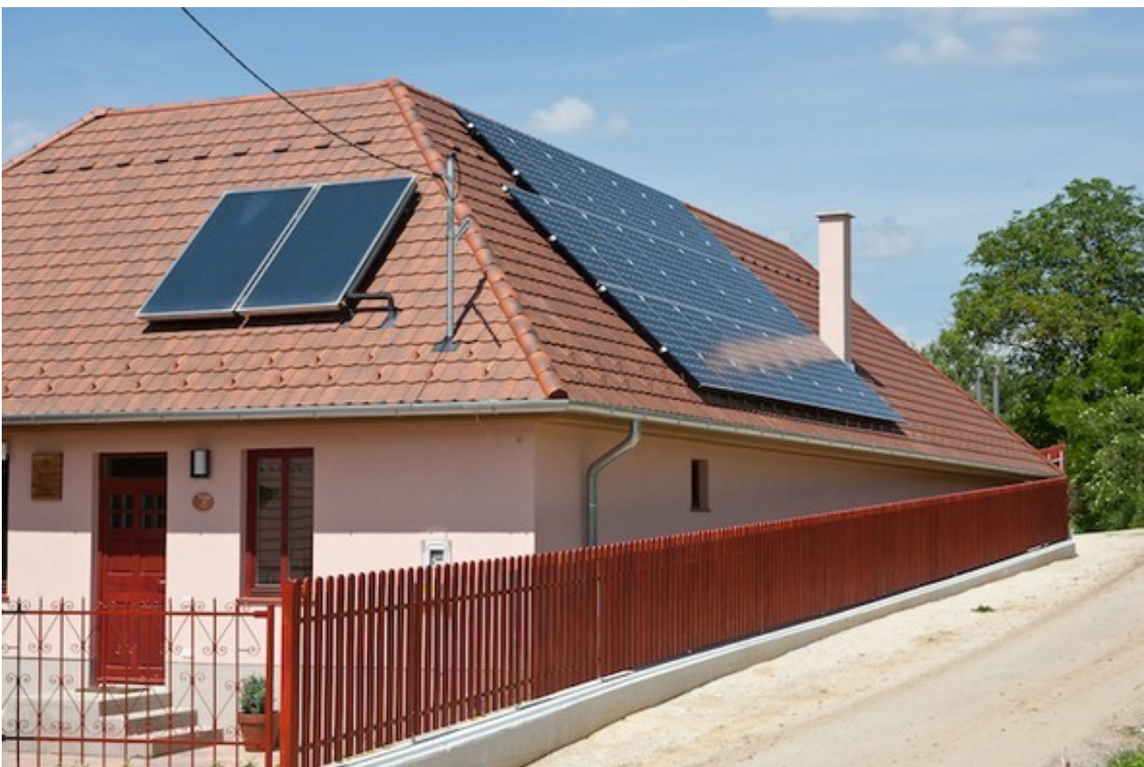
3. kép: 6,56 kWp fotovoltaikus napelem rendszer (jobbra) és napkollektorok (balra) az Irota EcoLodge Középső Házán.
