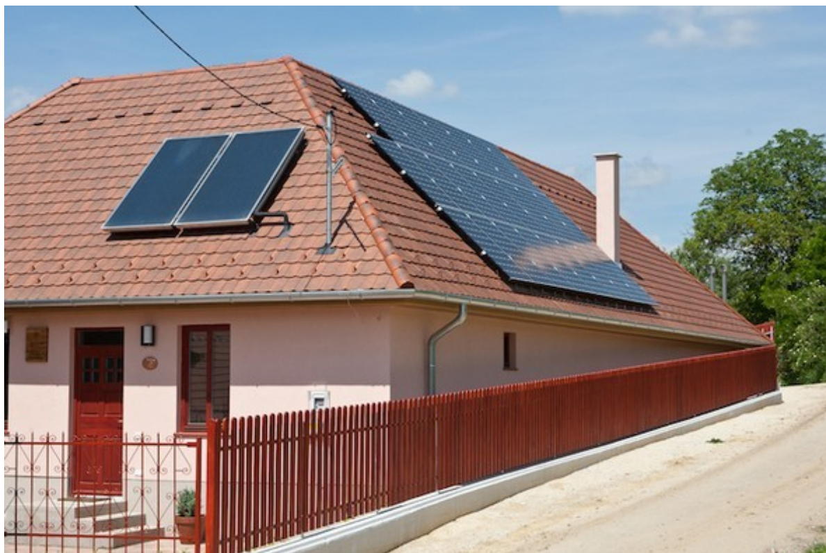
3. kép: 6,56 kWp fotovoltaiikus napelem rendszer (jobbra) és napkollektorok (balra) az Irota EcoLodge Középső Házán.
